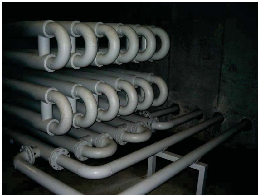
Фигура 11: Пример за топлообменник за предварително нагряване на входящите материали (биоотпадъци)
