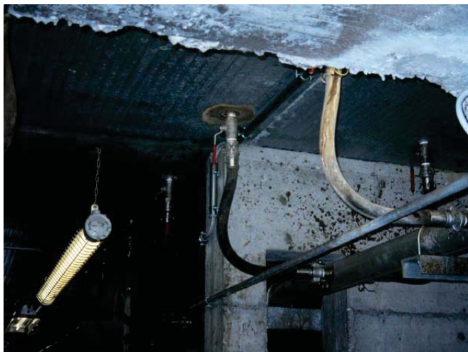
Фигура 10: Пример за биогаз, образуван на дъното на ферментатора (източник „Valorga“) и механичен смесител
