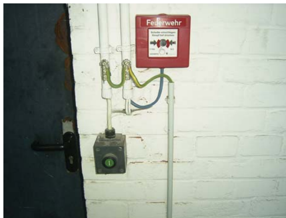
Фиг. 36. Защитен от експлозия ключ за включване/изключване на осветлението
