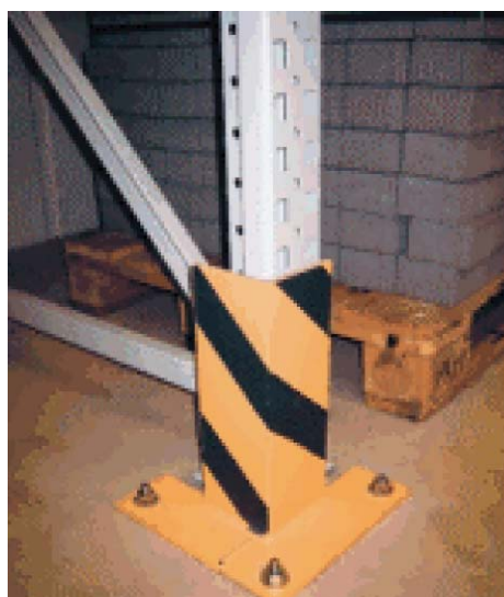
Фиг. 26. Защита на носещите елементи на рафтове
