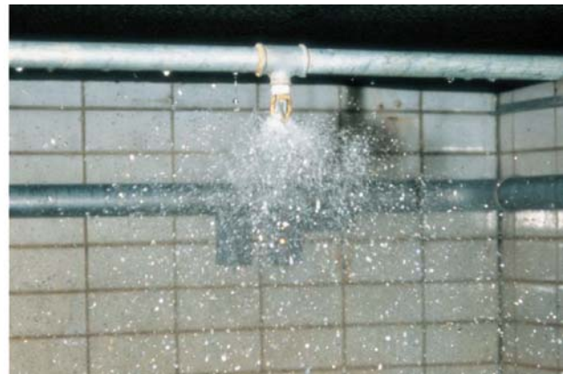
б) Активиран спринклерен противопожарен кран
