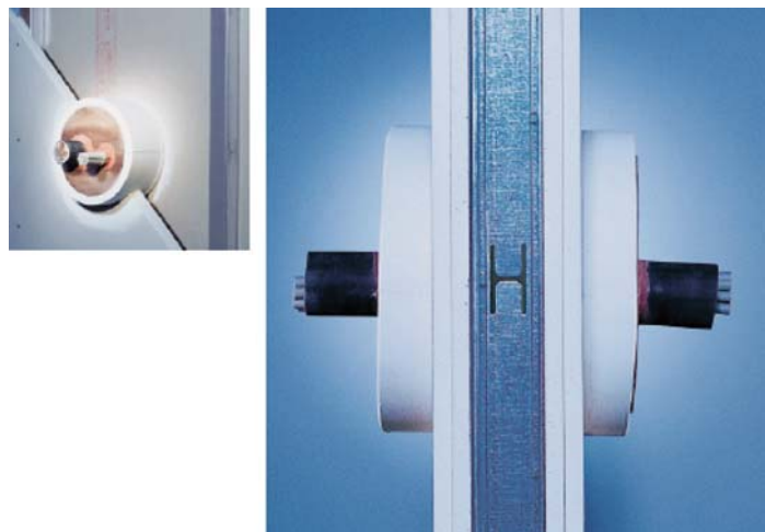
Фиг. 30. Прокарване на кабел през пожароустойчива стена F 90
