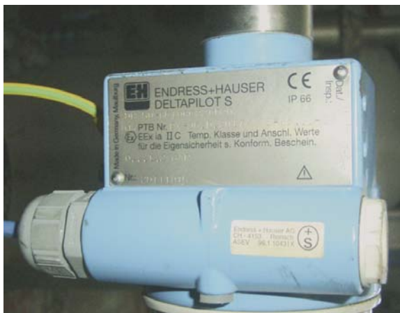
Фиг. 35. Нивомер, защитен от експлозия
