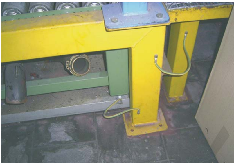
Фиг. 34. Заземяване на стоманен елемент
