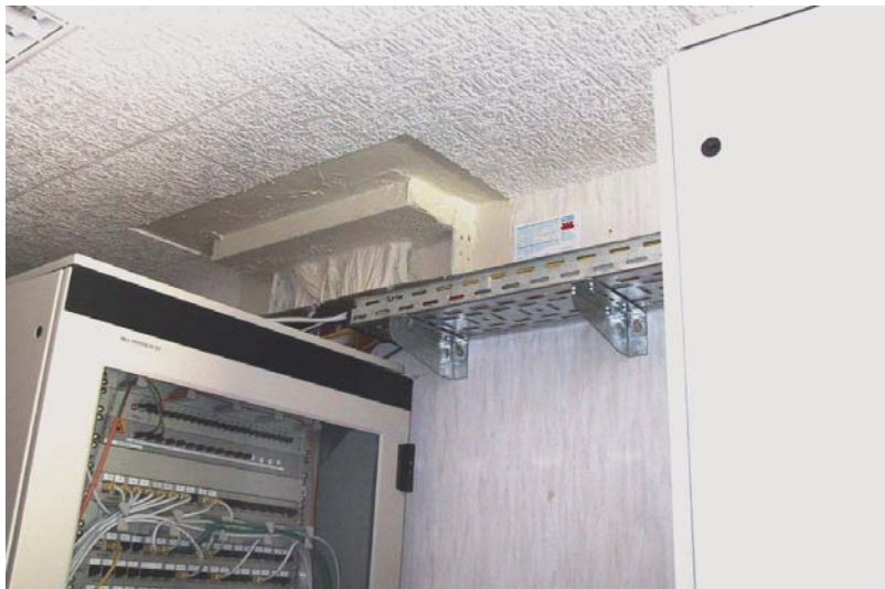
Фиг. 32. Прокарване на кабел с покритие F 90
