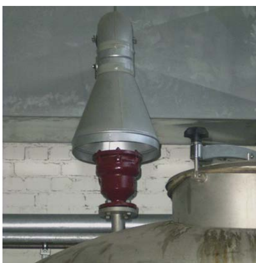
Фиг. 39. Пожароустойчива арматура на вентилатор – със защита от постоянен пожар
