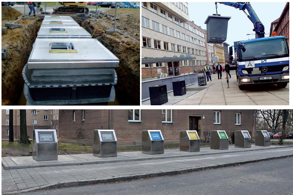
Фигура 16 – Изграждане на площадка за събиране с подземни контейнери.
