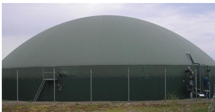
Фигура 15: Пример за съоръжение с твърда и гъвкава структура за съхранение на биогаз
