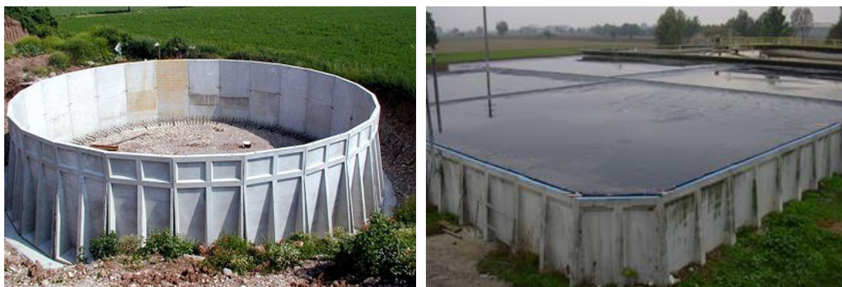
Фигура 16: Пример за непокрити и покрити съоръжения за съхранение на ферментационния продукт (остатъчна органична фракция от процеса на анаеробно разграждане)
