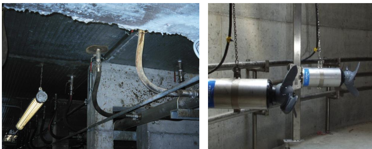
Фигура 10: Пример за биогаз, образуван на дъното на ферментатора (източник „Valorga“) и механичен смесител
