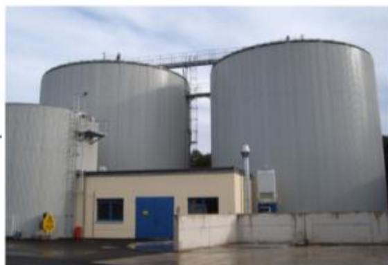
Фигура 2: Система за мокра ферментация във вертикални реактори
