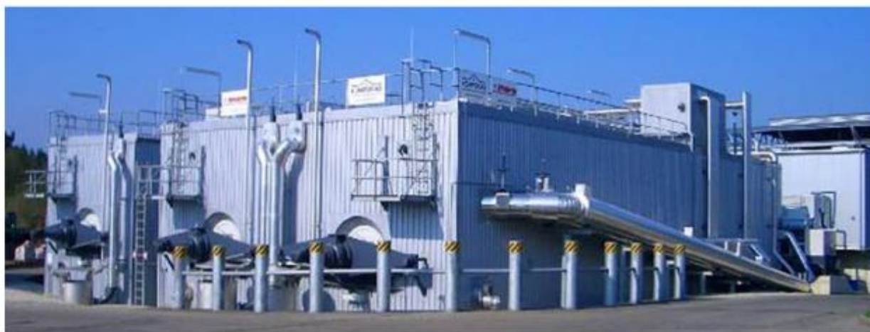
Фигура 3: Горизонтална система за суха ферментация, (източник: „Komprogas“)
