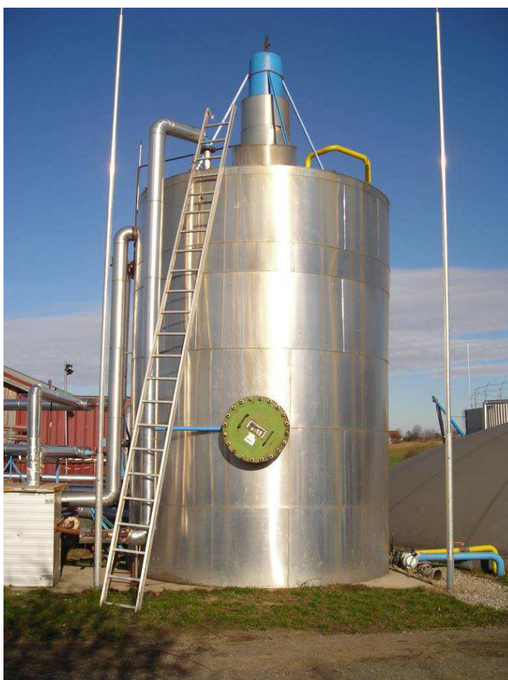
Фигура 8: Примерно оборудване за пастьоризиране (източник: „Bios1 GmbH“)
